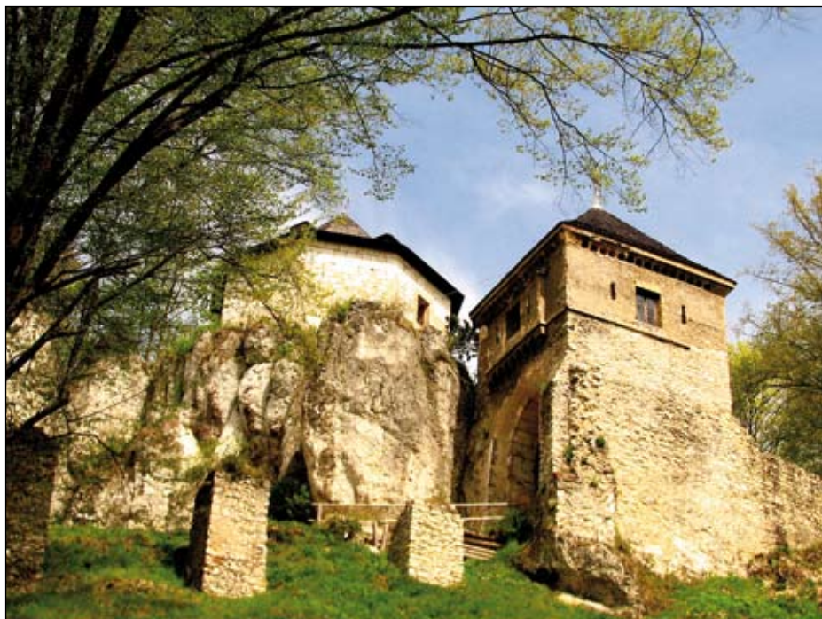
Ruiny królewskiego zamku w Ojcowie. Fot. Elżbieta Ługiewicz-Łbik
