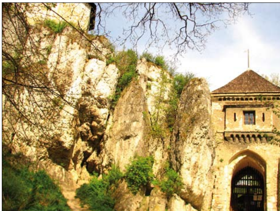
Brama wjazdowa do zamku w Ojcowie. Fot. Elżbieta Ługiewicz-Łbik
