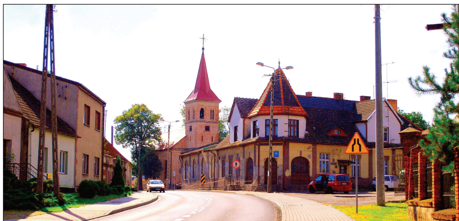
Budynek sali wiejskiej i centrum komunikacji społecznej, w głębi kościół ewangelicki. Fot. Wojciech Nawrocki
