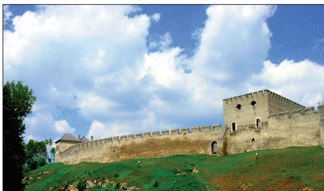
Mury obronne i zamek w Szydłowie. Fot. Jerzy Giergielewicz
